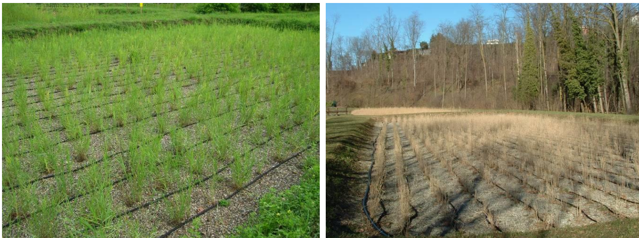
Figura 14. Sistema a flusso sub-superficiale verticale a Vizzola Ticino (VA) nelle diverse stagioni: in estate (a sinistra) e in inverno (a destra)
