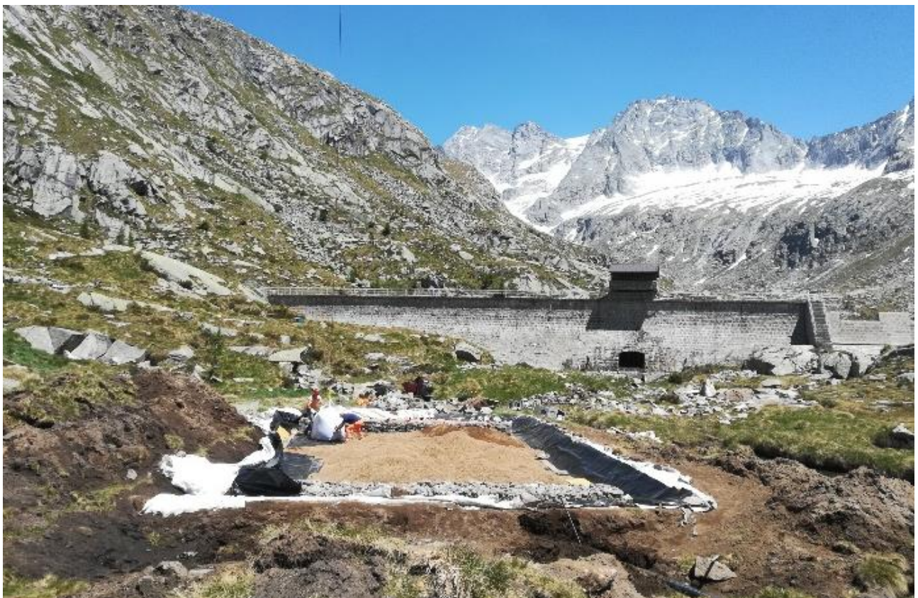
Letto di pedo-fitodepurazione durante la fase realizzativa
