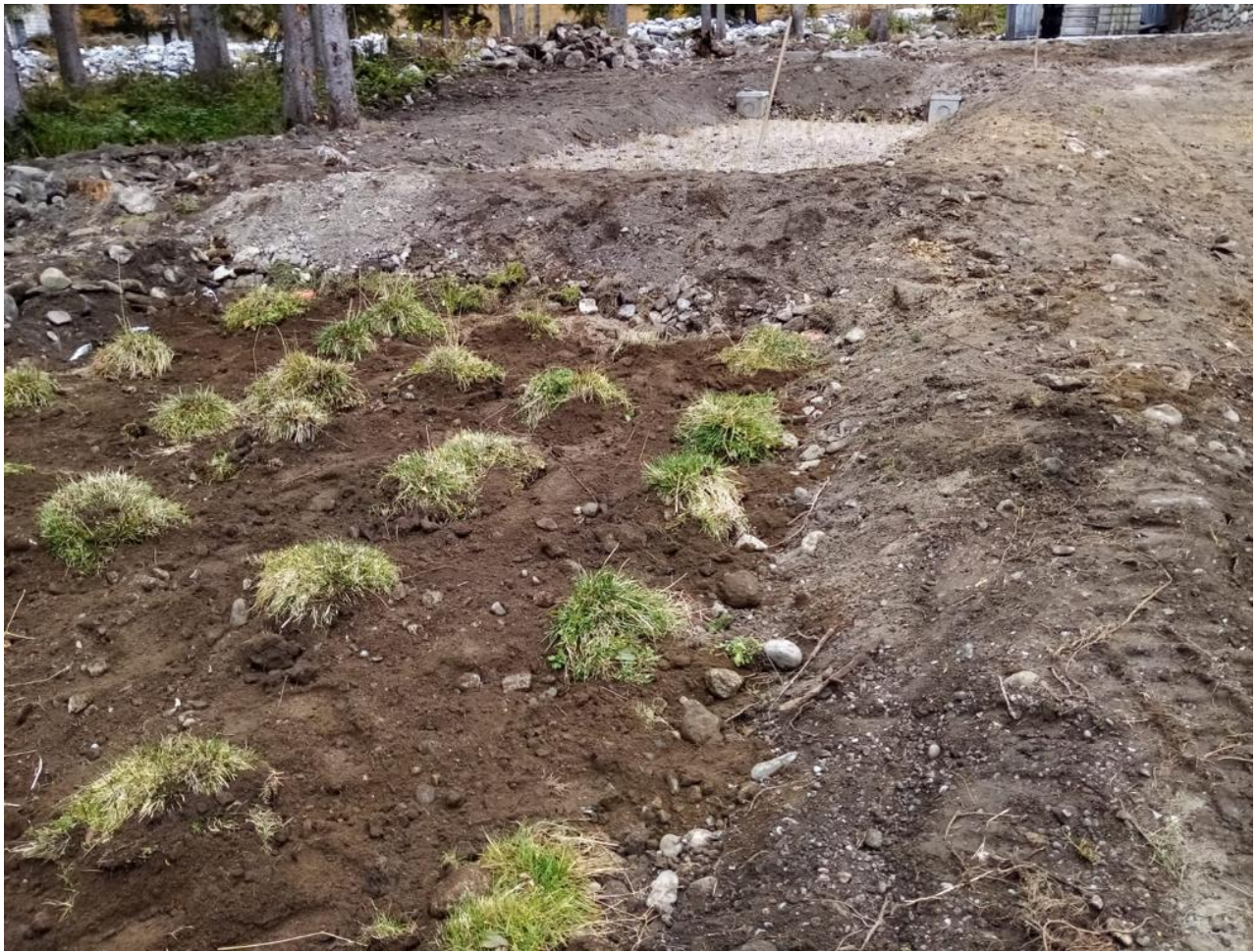
Figura 31. Posa delle zolle di Deschampsia caespitosa (in primo piano) e di Phragmites australis (sullo sfondo)
