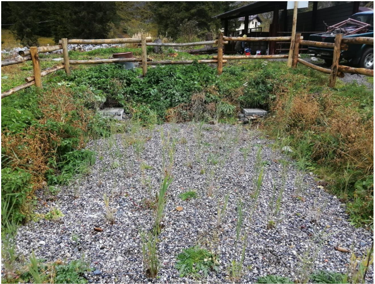
Figura 33. Particolare del letto A con le piantine di Phragmites australis appena messe a dimora
