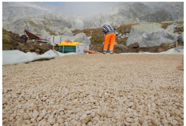
Riempimento del letto con zeolite
