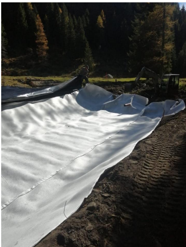
Figura 27. Posa del telo antipunzonante
