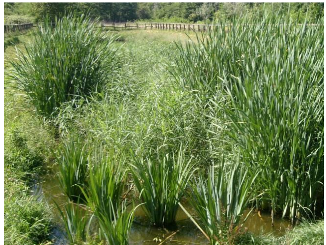
Figura 11. Sistema a flusso superficiale dell'impianto di Vizzola Ticino (VA)
