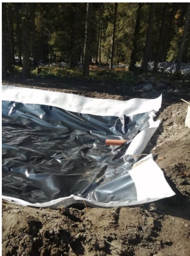
Figura 28. Posa del manto impermeabile in HDPE/LDPE
