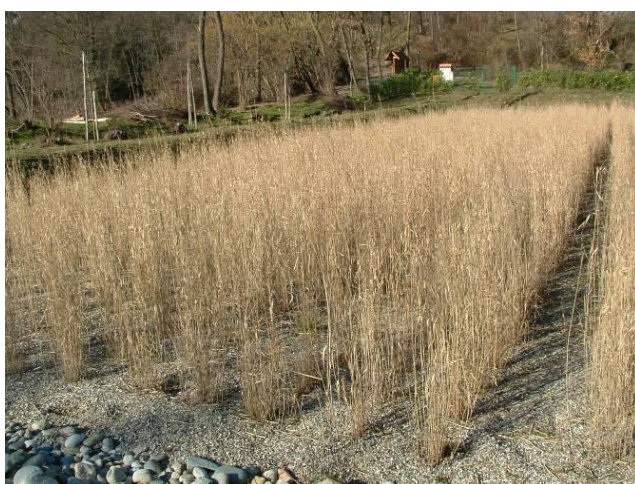
Figura 13. Sistema a flusso sub-superficiale orizzontale dell'impianto di Vizzola Ticino (VA) nelle diverse stagioni: in estate (a sinistra) e in inverno (a destra)
