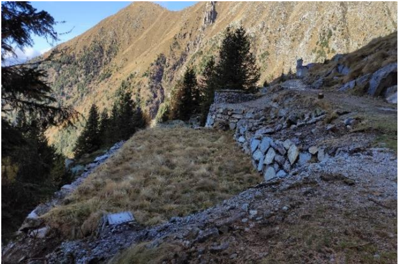
Documentazione fotografica – Fasi realizzative
