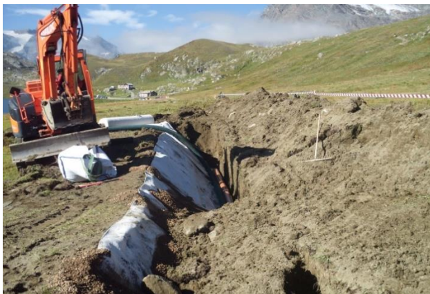
Fase realizzativa della trincea filtrante
