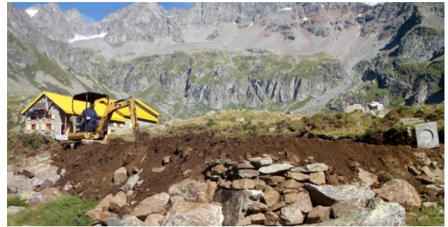
Base del letto di pedo-fitodepurazione
