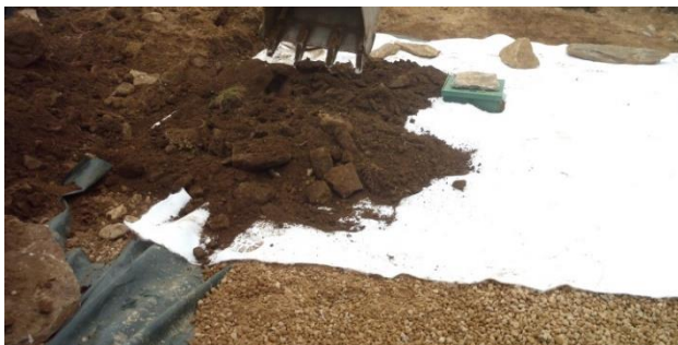
Copertura dello strato di zeolite con terreno vegetale
