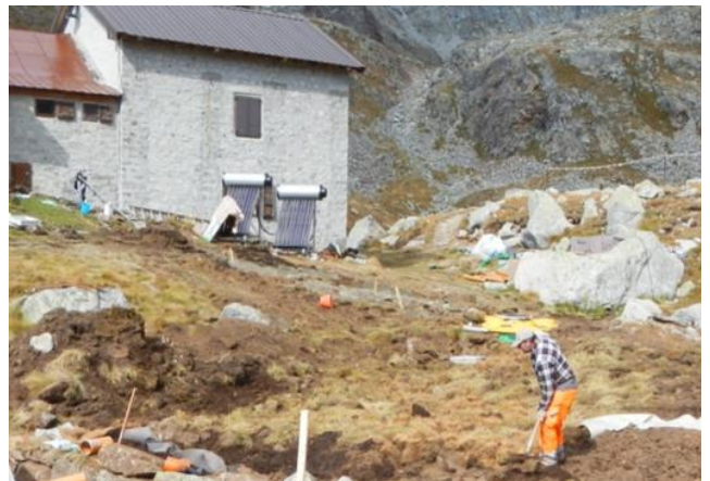
Copertura con terreno vegetale e zolle di specie autoctone di ambienti umidi locali
