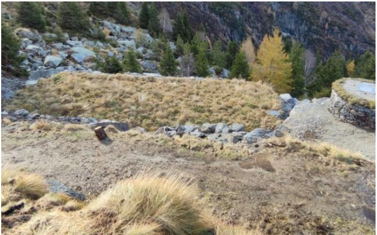
Documentazione fotografica – Fasi realizzative
