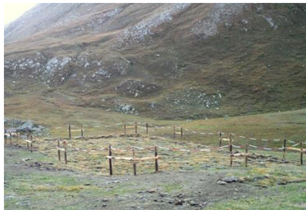
Ultimazione del bacino di pedo-fitodepurazione
