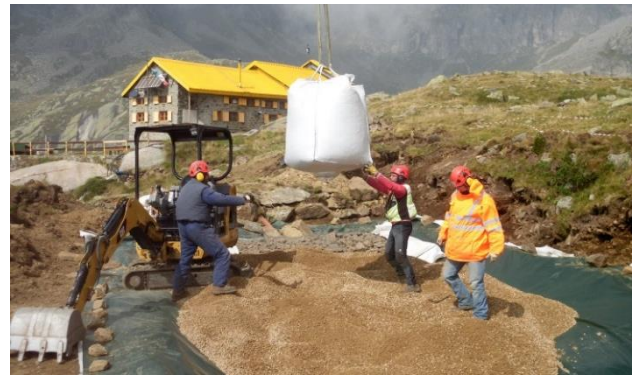
Fase di distribuzione della zeolite nel letto
