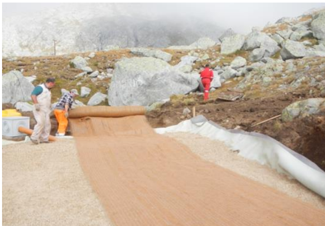
Posa di geotessuto di separazione dei substrati
