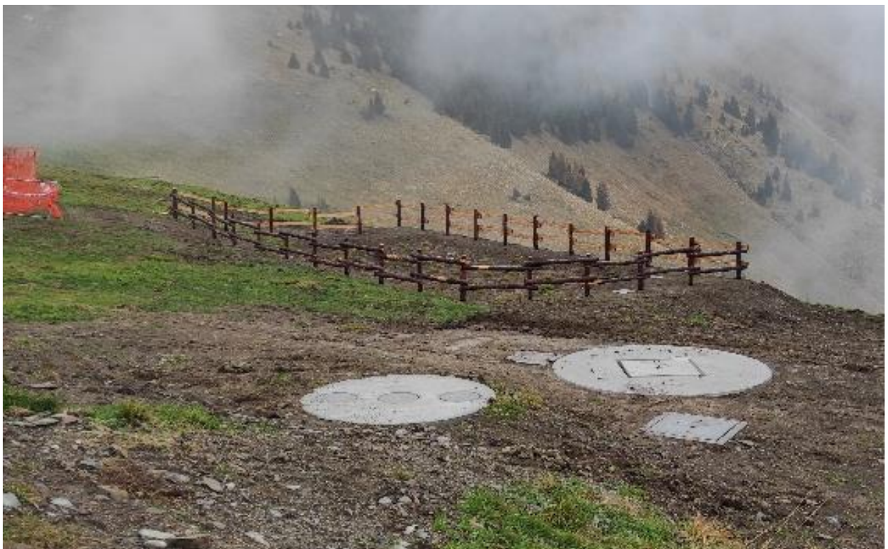
Documentazione fotografica – Fasi realizzative
