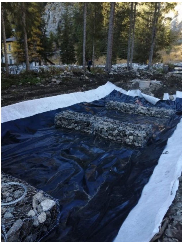
Figura 29. Posa dei gabbioni nel letto A
