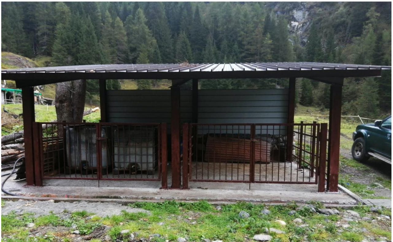
Figura 34. Struttura in acciaio dedicata all'alimentazione dei suini
