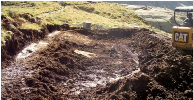
Preparazione del letto di pedo-fitodepurazione
