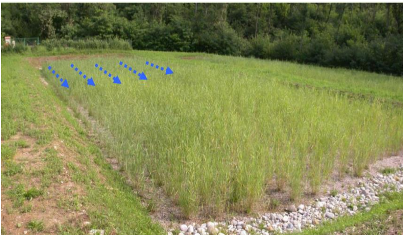
Figura 12. Esempio realizzativo di impianto di fitodepurazione a flusso sub-superficiale orizzontale con indicata la direzione del refluo
