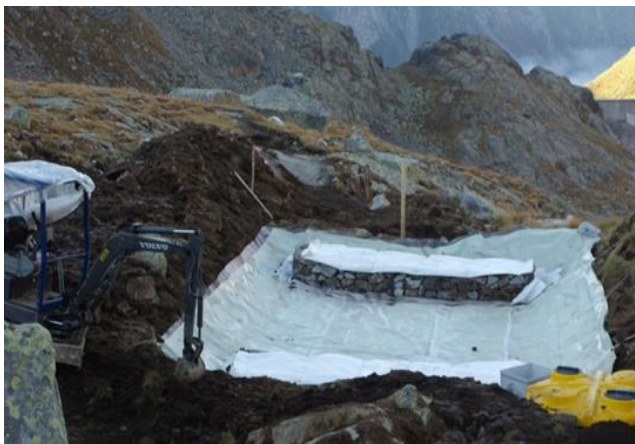
Impermeabilizzazione del fondo bacino con telo in PVC
