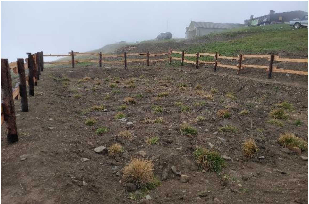
Documentazione fotografica – Fasi realizzative
