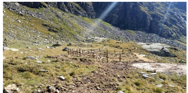
L'impianto di pedo-fitodepurazione a lavori ultimati
