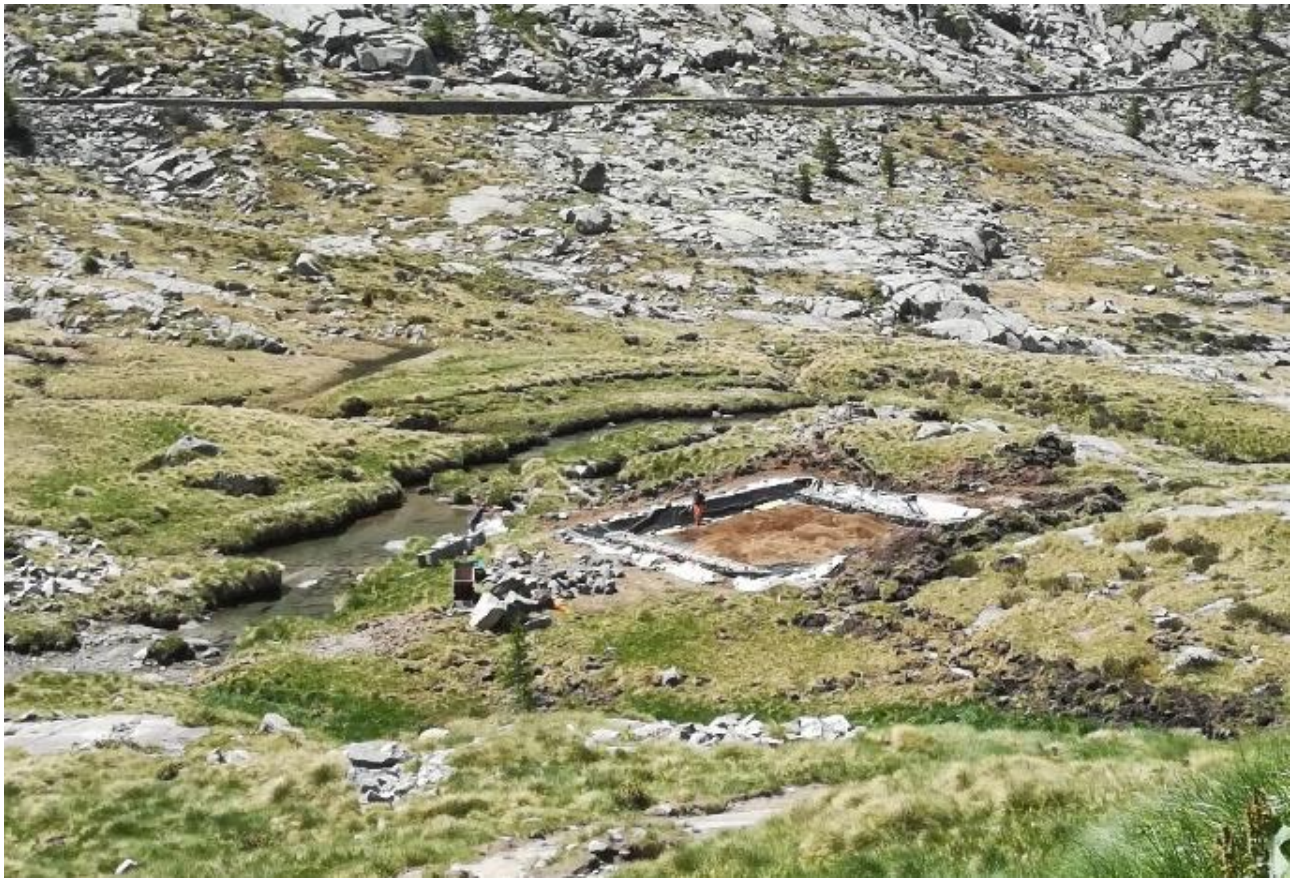
Panoramica dell'area di intervento durante la realizzazione dell'opera
