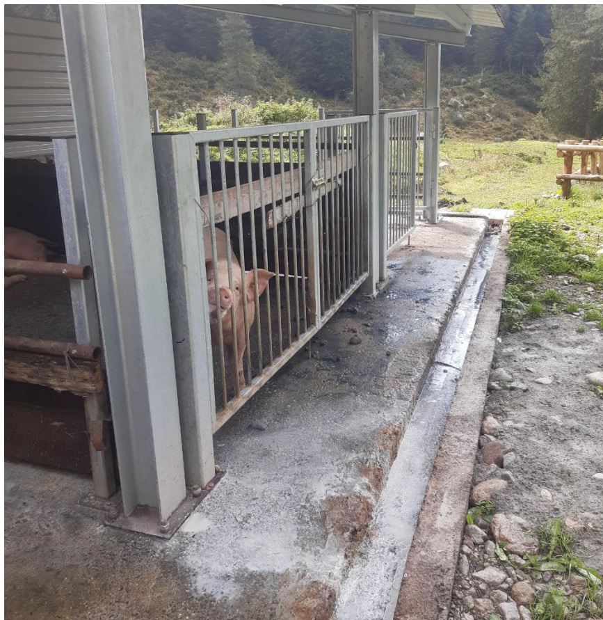
Foto 6: particolare recupero siero e coinvogliamento nel nuovo sistema di fitodepurazione
