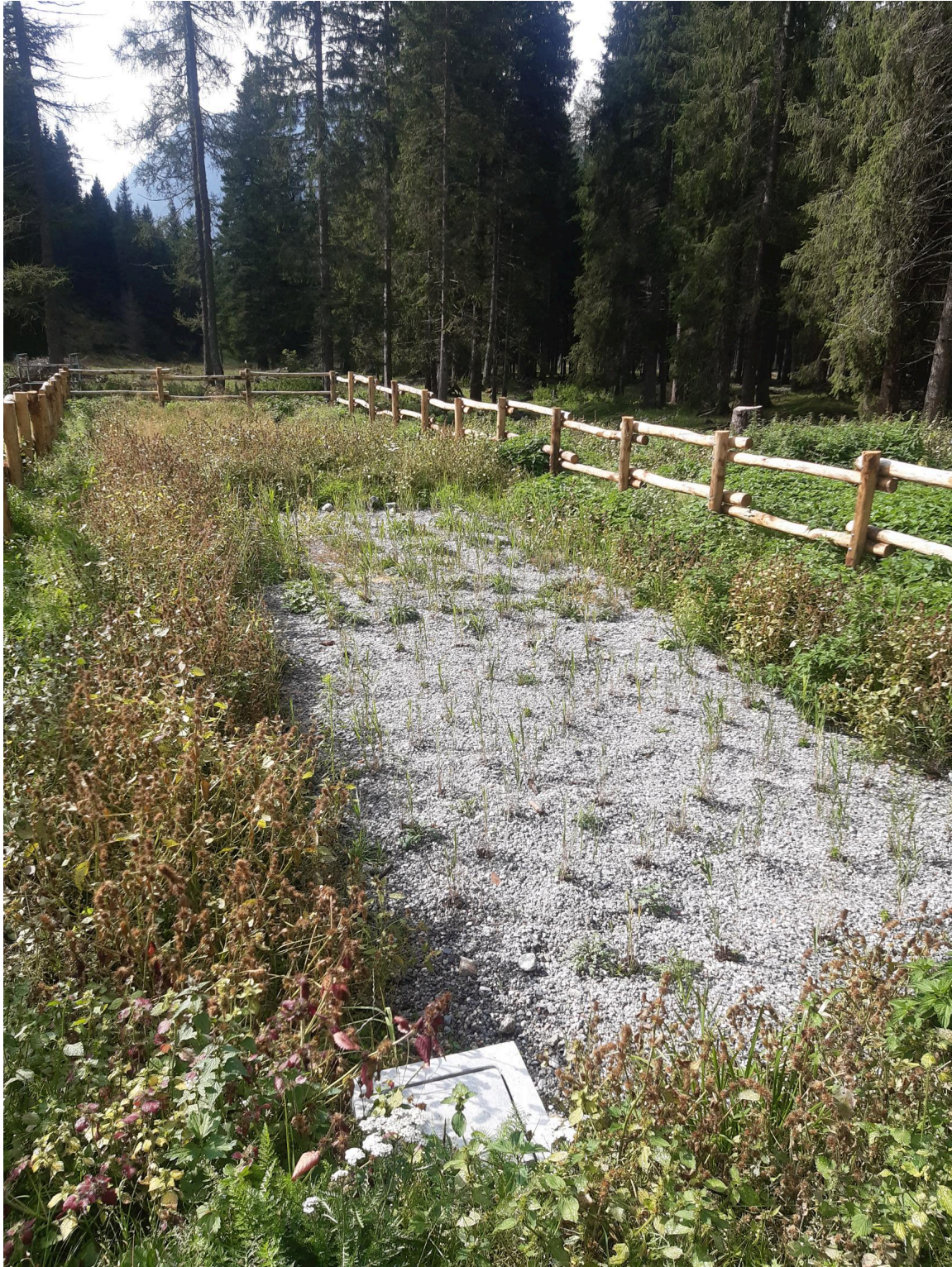
Foto 3: letti di fitodepurazione a fine 2022 – in primo piano il letto a Phragmites
